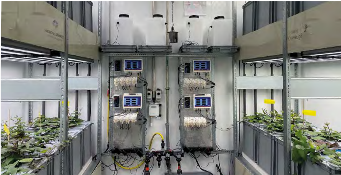
CEA-Anlage für Süßkartoffeln mit Steuer- und Regelungseinheiten
