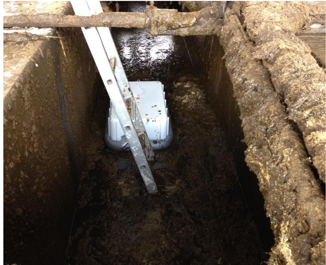
abgeschobener Flüssigmist in einer Vorgrube
